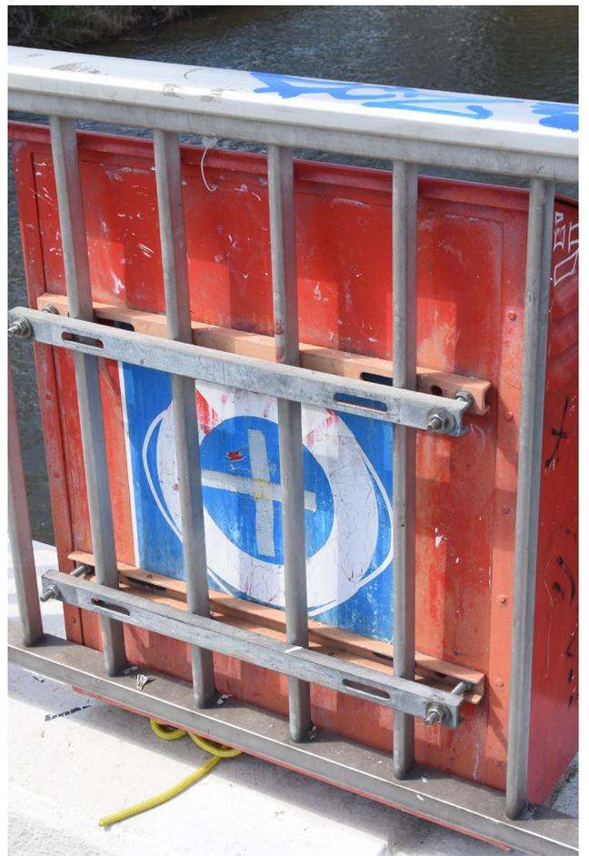
Die Befestigung der Trägerstange sollte eine Drehbewegung ähnlich einem Schwenkarm erlauben, so dass man bei Wartungsarbeiten die Installation in die Nähe des Geländers drehen kann.
