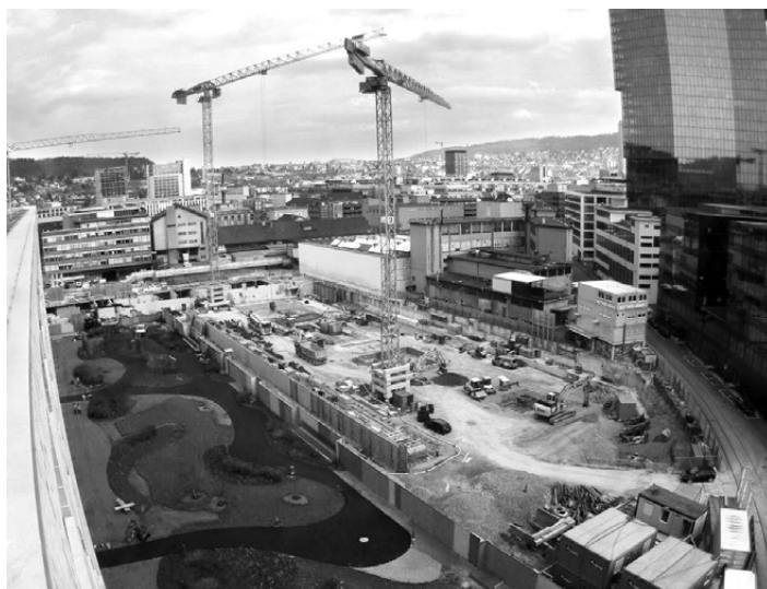
Bauarbeiten Maaghof Nord und Ost, 18. April 2013 Bezugstermin Wohnungen: Frühling 2015 Bildquelle: www.maag-ich.ch
