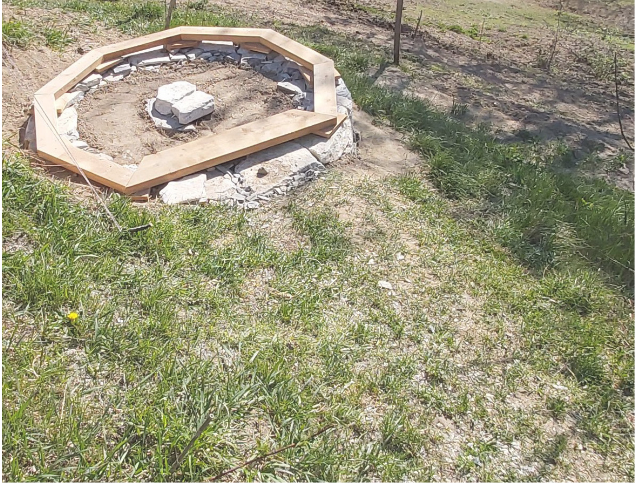
Kapelle bauen,* März 20 Formbauen und Beobachten bereiter Untergrung für den Holzstern
