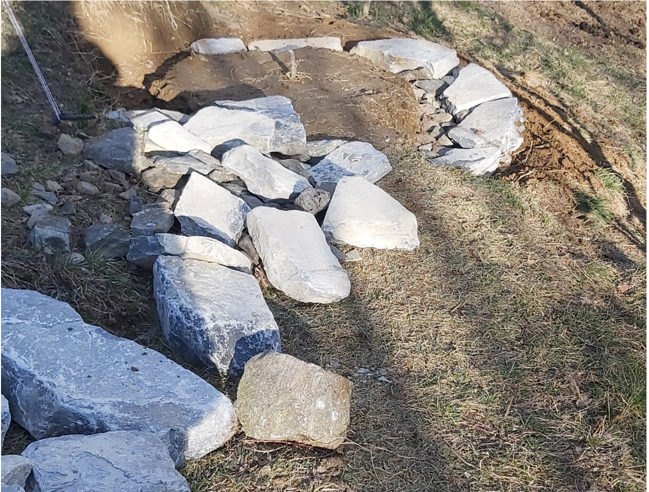
Kapelle bauen,* März 20 Formbauen und Beobachten Baugrube wird mit Steinen gefüllt
