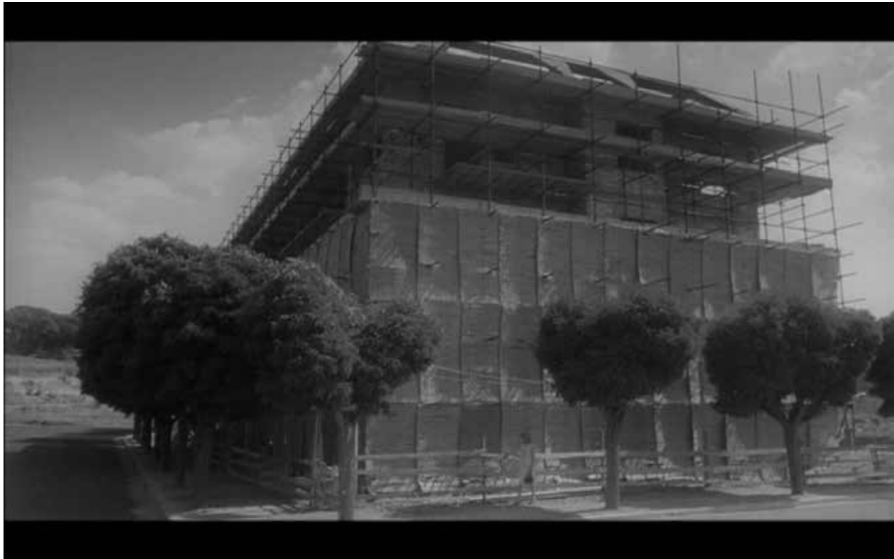
Der sich im Bau befindliche Wohnblock. Abb.63
