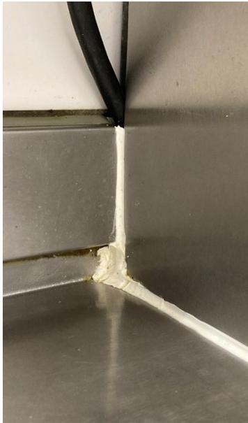
*Abbildung 28: Unvorteilhafte Geometrie einer Abdeckung, Silikonfuge zur Erleichterung der Reinigung, Verschmutzung am unteren Ende eines Kombiofens, Restaurant Trambly*
