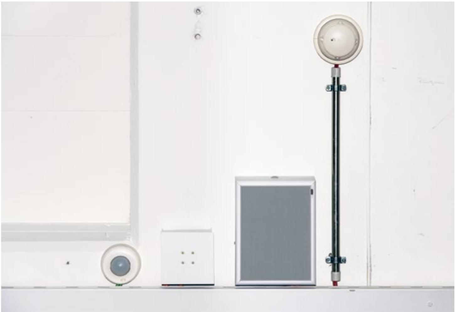
Audio Communication im Toni-Areal (von links): Bewegungsmelder, unbekannte Elektronik, elektroakustische Durchsageanlage, Rauchmelder. Foto Photograph: Regula Bearth. *Audio communication at Toni-Areal (from left): motion detectors, unknown electronics, electroacoustic announcement system, smoke detector.*
